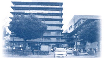
築48年の現市庁舎(南庁舎は築54年)
