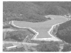
6/1 北野阿原一般廃棄物最終処分場に設置完成。今後20年間、一般家庭680世帯の使用電力を発電。
