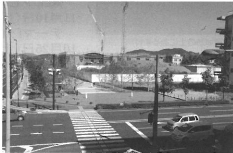
新市庁舎の建設予定地(岐阜大学医学部等跡地)
